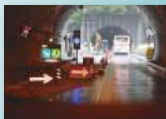
Tunnel di servizio e di manutenzione, cantieri edili
